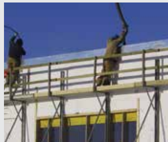
5 Pour the concrete
